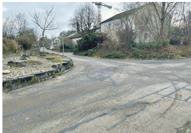
See- und Gartenstrasse werden ab diesem Sommer saniert.
