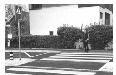
Seit Ende 2020 mehr Sicherheit für Fussgänger auf Höhe der Bushaltestelle Forrenbergstrasse.
