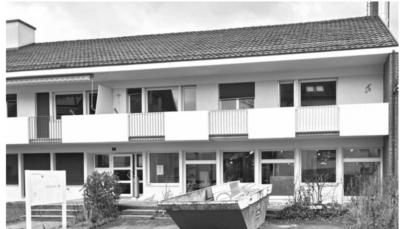
Am alten Standort in der Strehlgasse wird geräumt...
