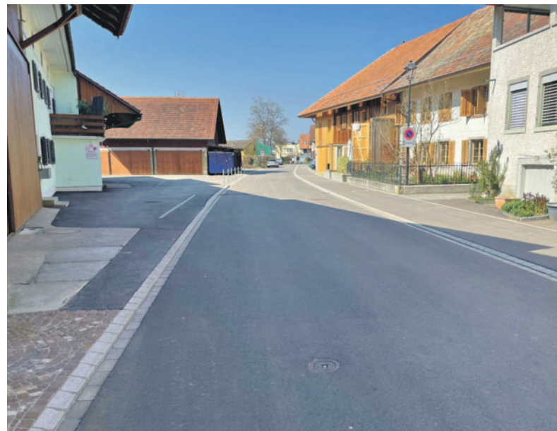
Die Püntenstrasse konnte deutlich günstiger saniert werden als budgetiert.
