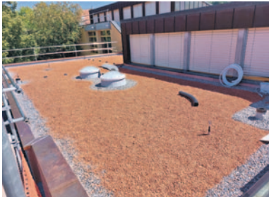
Auch auf dem kürzlich sanierten Flachdach der Turnhalle Oberohringen werden Solarmodule installiert.
