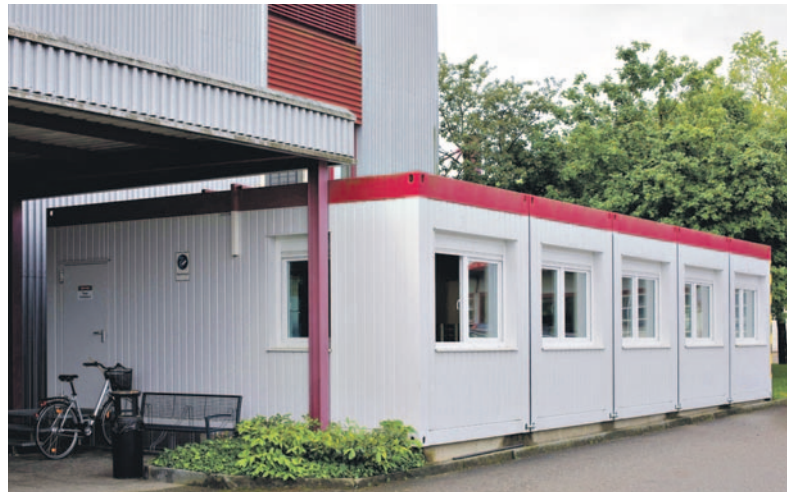
Die fünf Bürocontainer der Schoch Vögtli AG werden durch ein sechstes Modul ergänzt.
