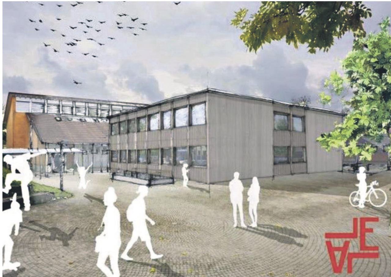
2023 werden rund 3 Millionen Franken in das Projekt LeLa investiert, das nun im Holzmodulbau realisiert wird.
