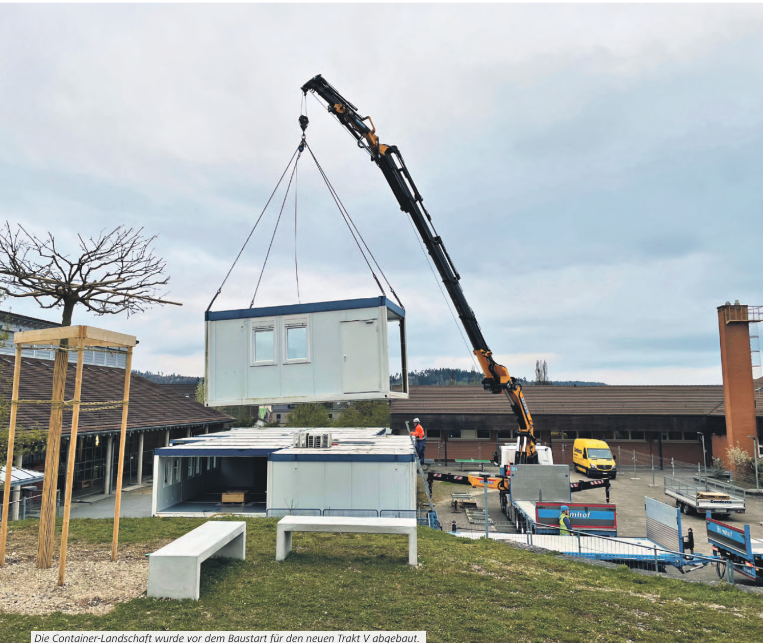
Die Container-Landschaft wurde vor dem Baustart für den neuen Trakt V abgebaut.
