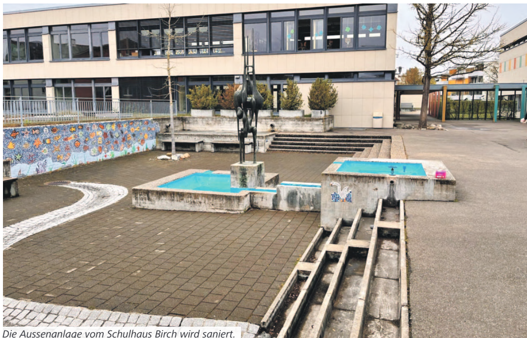
Die Aussenanlage vom Schulhaus Birch wird saniert.
